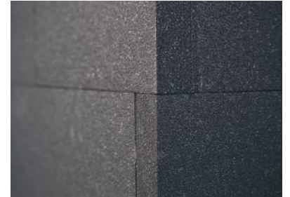
Şekil 3 Isı yalıtım levhaları, duvarın alt kısmından başlanarak yukarı doğru aralıksız ve şaşırtmalı olarak döşenir. Köşelerde de levhalar şaşırtmalı olarak yerleştirilmelidir.
