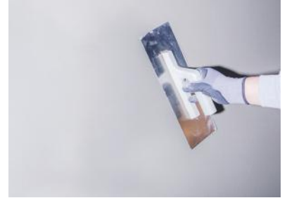
Şekil 3 Hava durumuna bağlı olarak ilk kat sıva harcının hafifçe suyunu atması beklenerek ikinci kat sıva harcı uygulaması tamamlanır.
