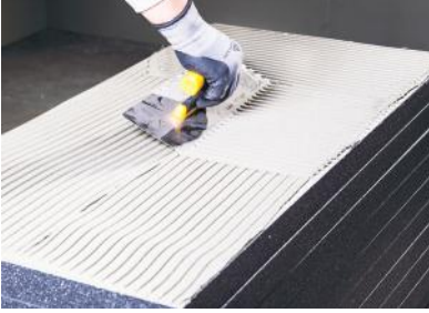
Şekil 1 Yüzey düzgünse "Tüm Yüzeye Yapıştırma Metodu" uygulanarak yapıştırma harcı ısı yalıtım levhasının tamamına mala veya uygun bir taraklı malayla sürülür.
