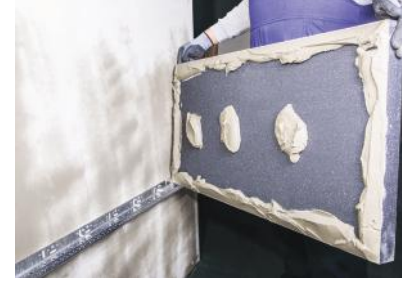
Şekil 3 Isı yalıtım levhasının arkasına yapıştırma harcı uygularken kenarlardan taşmamasına dikkat edilmelidir.
