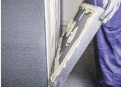
Şekil 1 Arkasına yapıştırma harcı sürülen ısı yalıtım levhası, subasman profiline boşluksuz olarak yerleştirilmelidir.
