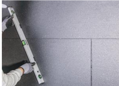
Şekil 2 Yalıtım levhaları, duvarla tam temas edecek şekilde hafifçe kaydırılarak duvara yapıştırılır. Levha seviyelerinin kontrolü master veya su terazisiyle sağlanmalıdır.
