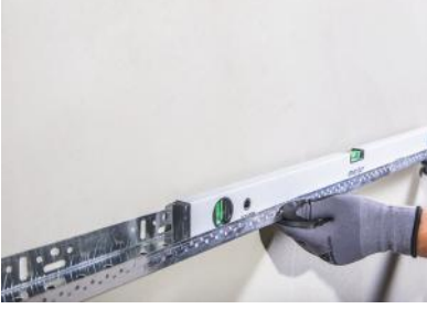
Şekil 1 İstanbul Mavi Subasman Profil Montajı, mantolama sisteminin dengeli ve düzgün olmasını sağlar. Yüzeyde olası eğrilikleri düzeltmek için duvar ile subasman profili arasındaki boşluklar, girintiler ve çıkıntılar farklı kalınlıklardaki takozlarla düzeltilerek yüzey gönyeye alınır.
