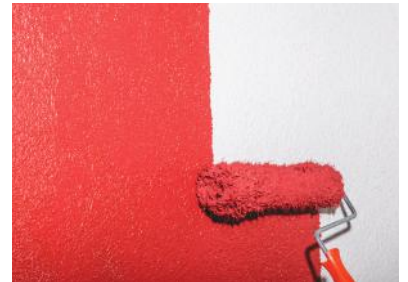
Şekil 3 Son olarak dış cephe astar ve boya uygulaması yapılır.
