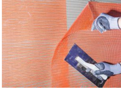
Şekil 2 Donatı filesi, henüz kurumamış ilk kat yüzey sıvasının üzerine, yukarıdan aşağıya doğru bastırılarak ve iyice gerilerek, katlanmadan ve yalıtım levhasından tüm yüzeye eşit uzaklıkta olacak şekilde yerleştirilmelidir. Birleşim yerlerinde donatı filesi, her zaman 10 cm üst üste bindirilerek uygulanmalıdır.
