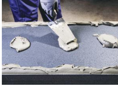
Şekil 2 Yüzeyde seviye farklılıkları ya da eğrilikler varsa "Şerit ve Noktasal Sürme Metodu" uygulanarak yapıştırma harcı ısı yalıtım levhasının arkasına tüm kenarlar boyunca kesintisiz olarak şerit halinde, orta bölümlerine ise noktasal halde malayla sürülür.
