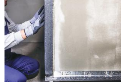
Şekil 3 Aralarında 2-3 mm mesafe bırakılarak uç uca eklenen su basman profillerinin ölçüsü kullanılacak ısı yalıtım levhasının kalınlığına uygun olarak seçilmelidir.
